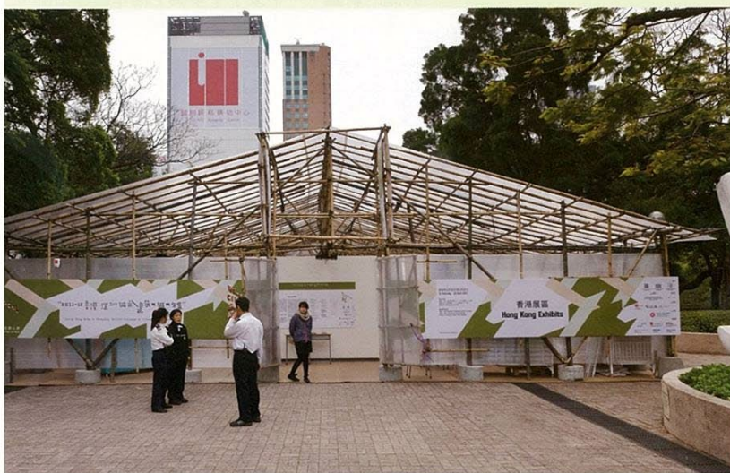
香港展外觀，以竹構架和耐力板組成的構造。
